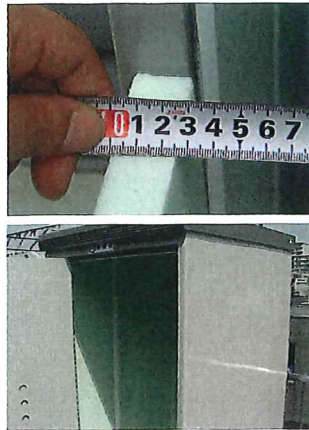
▲断熱材物置には、厚さ25mmのスタイロフォームを、天井、内壁、扉部分に貼り付けた。
